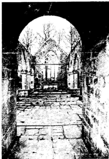
PONT-L'ABBÉ. — Treize ans de travail régulier auront été nécessaires pour remettre la chapelle de Languivoa en état. Prochaine étape : la toiture.
